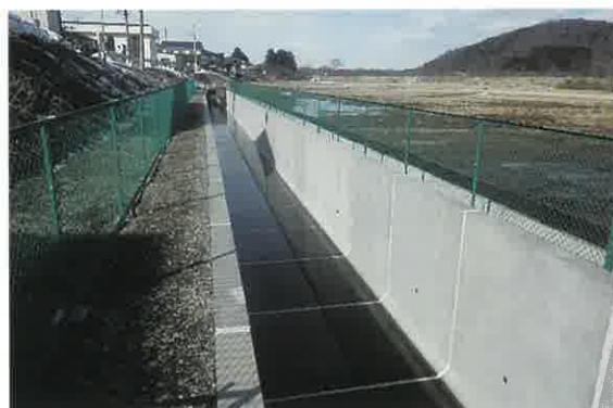
R5 南川第三排水区開渠設置工事
