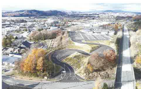
【令和7年春 開業予定】 盛岡市道の駅建設(造成)工事
