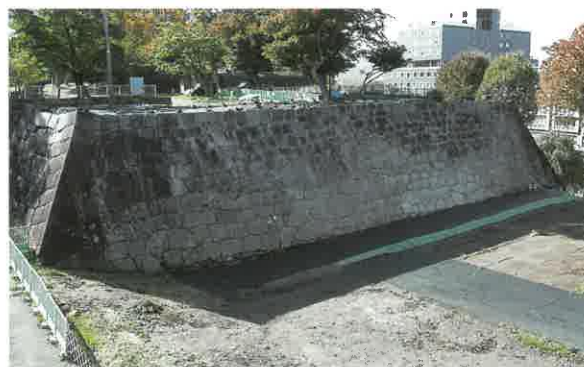
史跡盛岡城跡三ノ丸北西部石垣修復等工事
