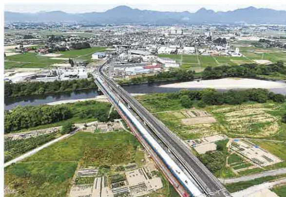
一般県道大ケ生徳田線徳田地区ほか道路改良舗装(その2)工事
