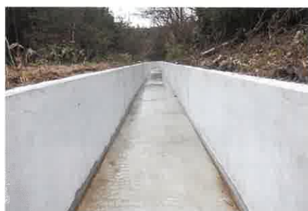
水路改修工事
