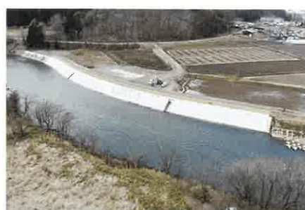
河川改修工事
