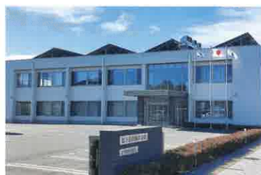
樋下建設(株)本社社屋
