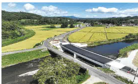
●雪浦橋上部工整備工事
