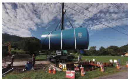
防火水槽タンク 設置施工
