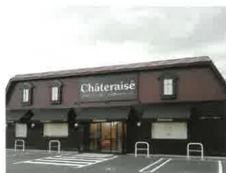
店舗新築工事
