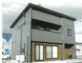
住宅新築工事
