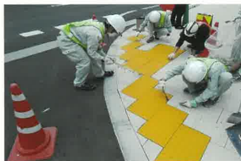
点字ブロック設置工事
