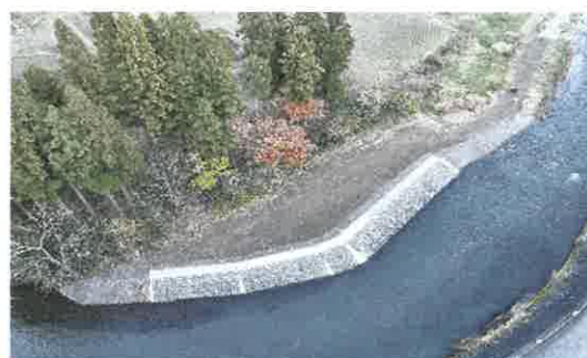
●小田橋下地区河川災害復旧工事
