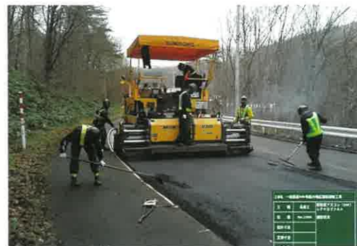
一般国道455号薮川地区舗装補修工事施工状況
