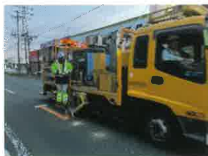
区画線設置工事
