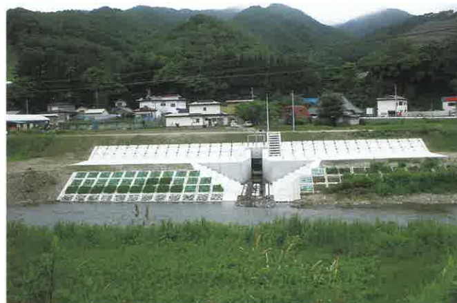
築堤護岸工事
