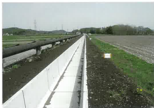
農村災害対策整備事業岩手山麓地区第18号（北部幹線）工事
