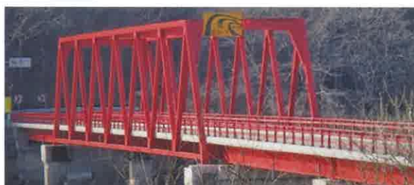
盛岡環状線岩姫橋橋梁補修工事
