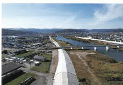
築堤護岸工事
