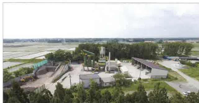
北上アスコン及び北上資材センター
