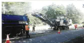
国道4号舗装修繕工事
