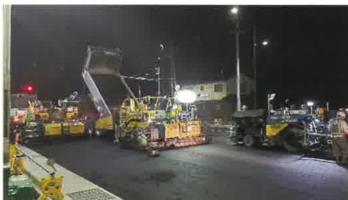
アスファルト舗装工事 (岩手医大前道路)
