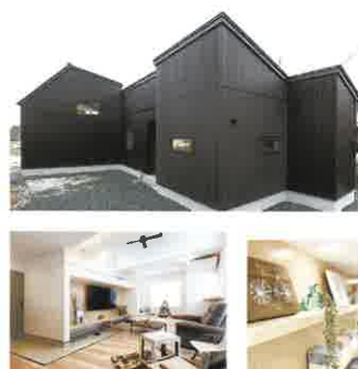
【ASK × HOUSING】 H様邸新築工事
