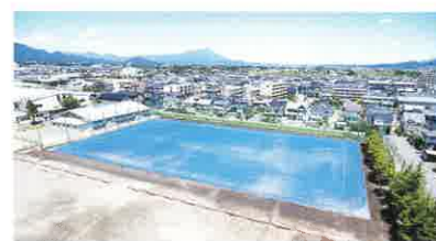
岩手県立不来方高等学校ホッケー場整備工事
