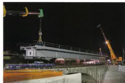
氷上橋歩道橋 製作施工 (陸前高田市)
