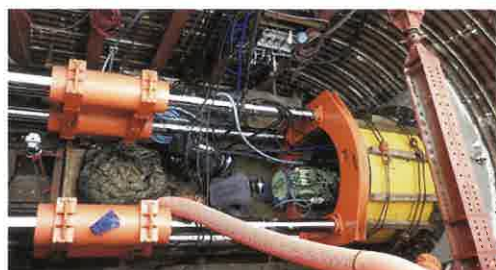
大釜排水区雨水幹線工事
