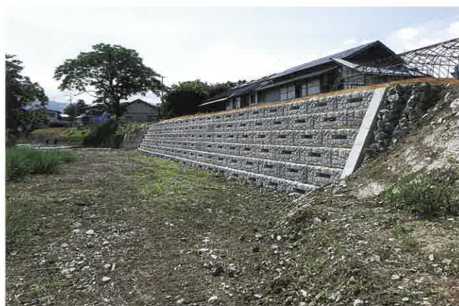
河川災害復旧工事
