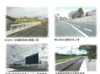
からまゝ完成(仮称)建設工事 城山地区道路改良工事 (仮称)盛岡市立総合センター整備道路 事業建設工事 水利施設等総合高度化事業 松川大開地区第2号工事
