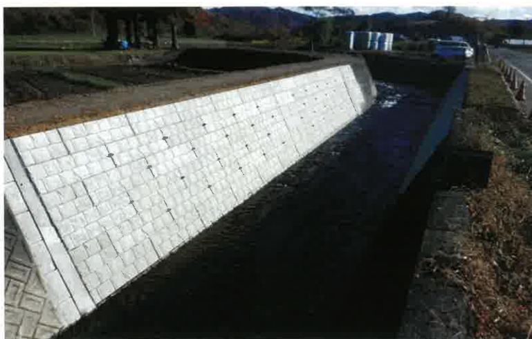
一級河川宇別川筋宇別地区河川災害復旧(4災55号)工事
