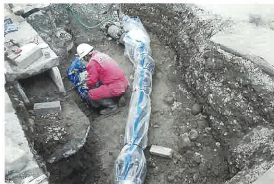
水道本管布設工事
