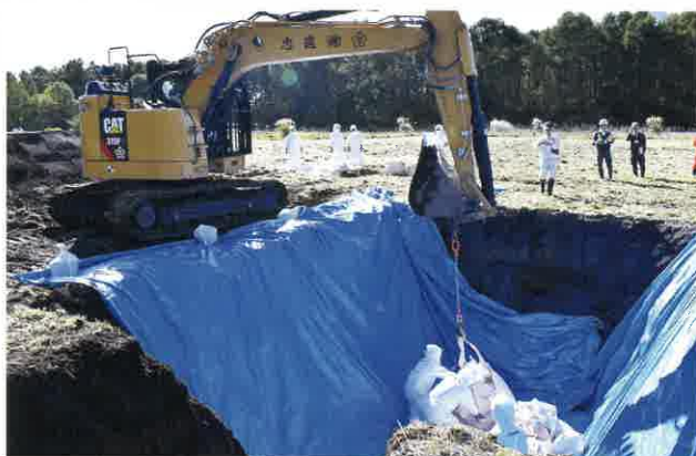
バックホウを使って掘削溝内で積み下ろし
