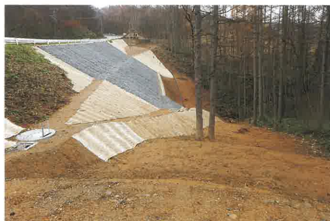
道路災害復旧工事
