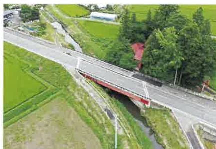
橋梁補修工事
