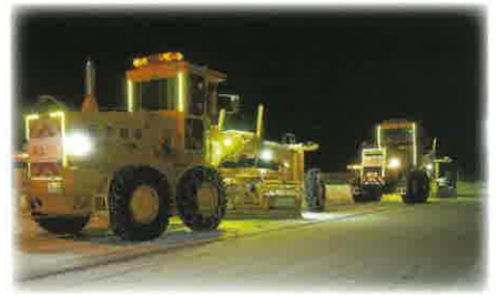
冬期の除雪作業状況
