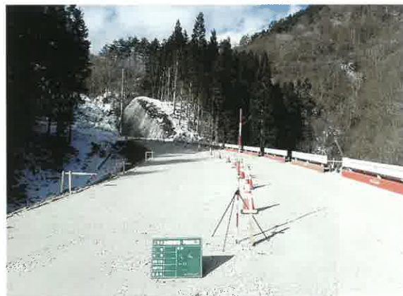
令和6年度優良県営建設工事表彰受賞 令和4年度(繰越) 森林基幹道安孫・平糠線改築工事
