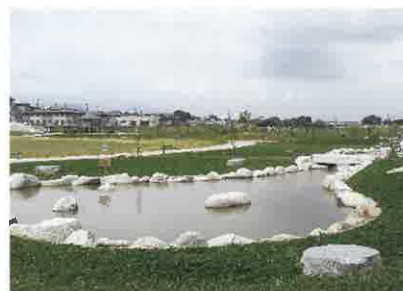
公園工事 (旧盛岡競馬場跡地)
