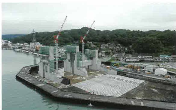
閉伊川筋水門土木工事
