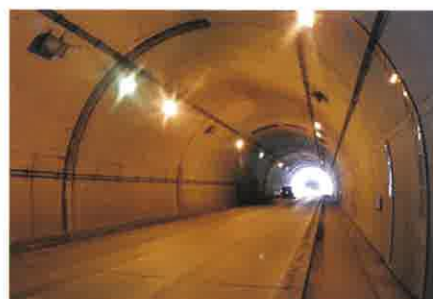
トンネル補修工事
