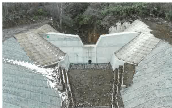
大白沢(1)地区復旧治山工事
