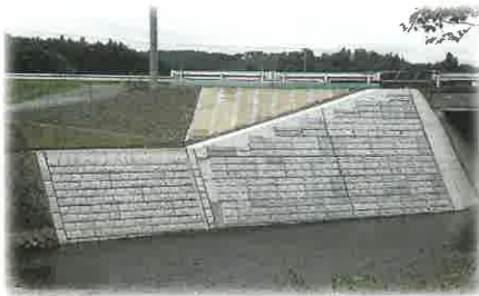
河川災害復旧護岸工事
